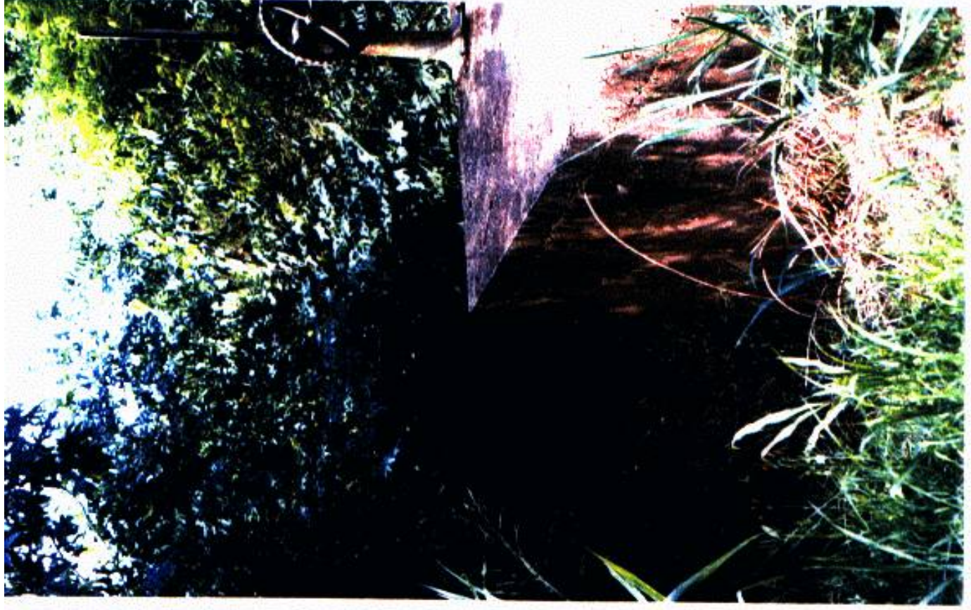
Figura 28e. Comporta de regulação da entrada do rio São Francisco na lagoa de Don Pedro. Localizada a jusante da foz do rio das Velhas.
