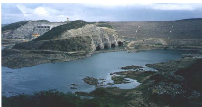
Foto 1. Barragem da UHE Xingó
